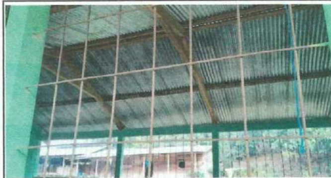
Foto 4: Mantenimiento de balcon.
