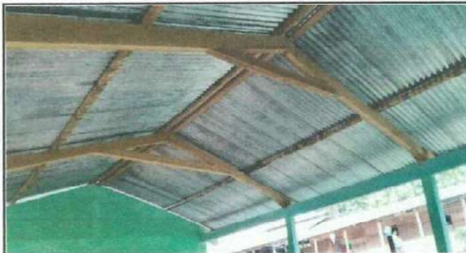
Foto 2: Cambio de costanera.
