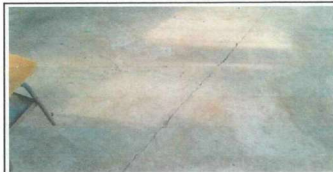
Foto 6: Sustitucion de piso.
