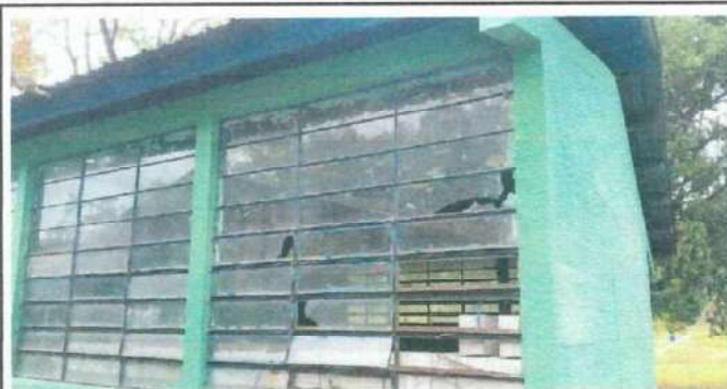
Foto 3: Cambio de vidrios.
